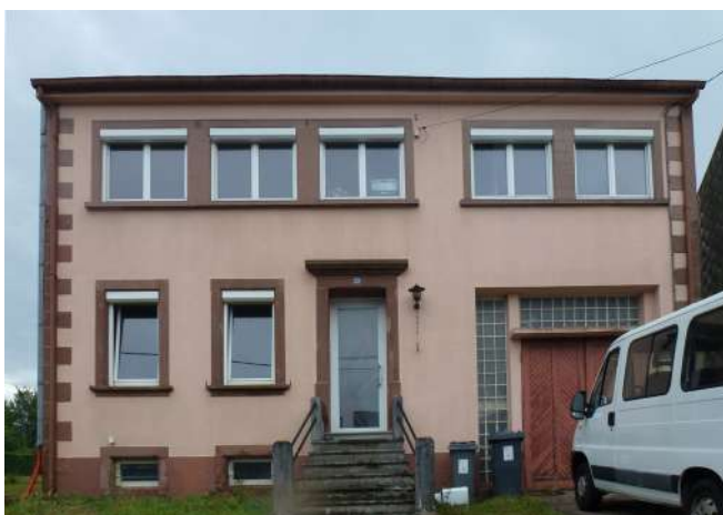
Illustration 15: rue de Rohrbach, installation de menuiseries en PVC et caissons de volet roulant apparents sur du bâti ancien
