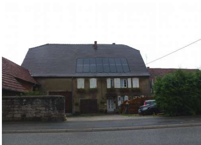
Illustration 16: rue de Rohrbach, installation de panneaux solaires sur du bâti ancien
