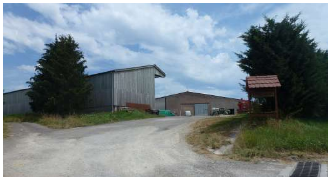
Illustration 11: bâtiments agricoles, rue de Montbronn
